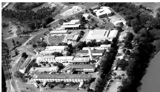
Figura 6.18 Campus I da Escola de Engenharia de Lorena (EEL USP)
